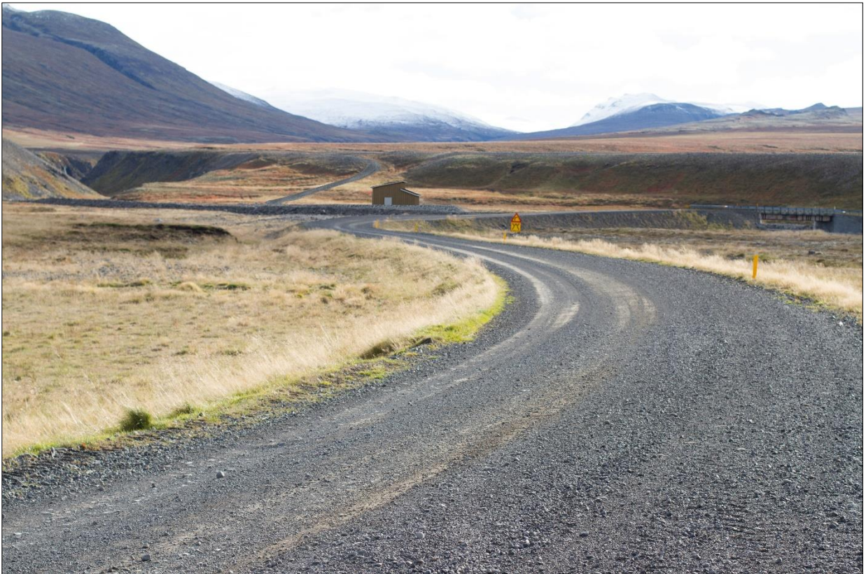
Mynd 5.1 Fyrirhugað stöðvarhús og aðkomuvegur. Mynd tekin af Sunnudalsvegi.
