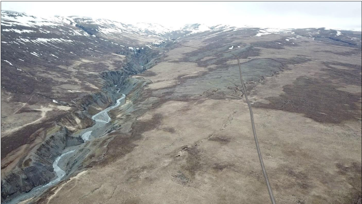
Mynd 5.3 Fyrirhugaður vegur upp að stíflu, meðfram þrýstipípu sem er niðurgrafin.
