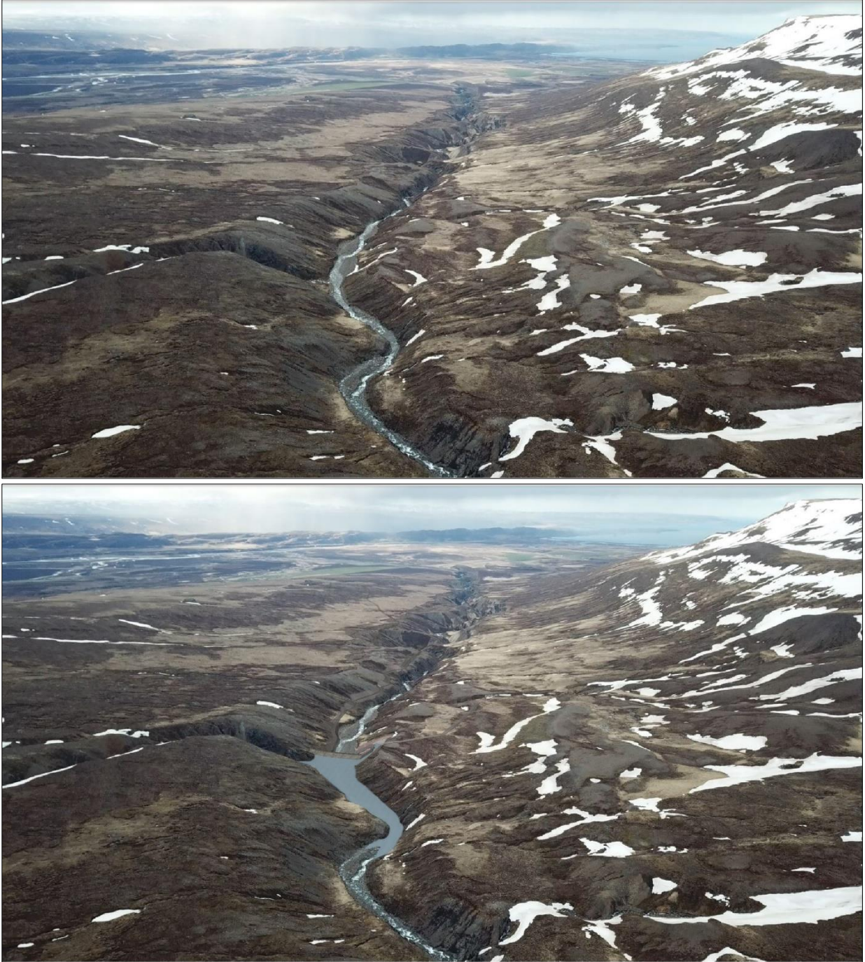
Mynd 5.5 Inntakslón og stífla í forgrunni. Á neðri mynd má sjá hvar þrýstipípa og vegur liggur eftir gílinu fyrstu 1.500 m áður en komið er upp á sléttara land.
