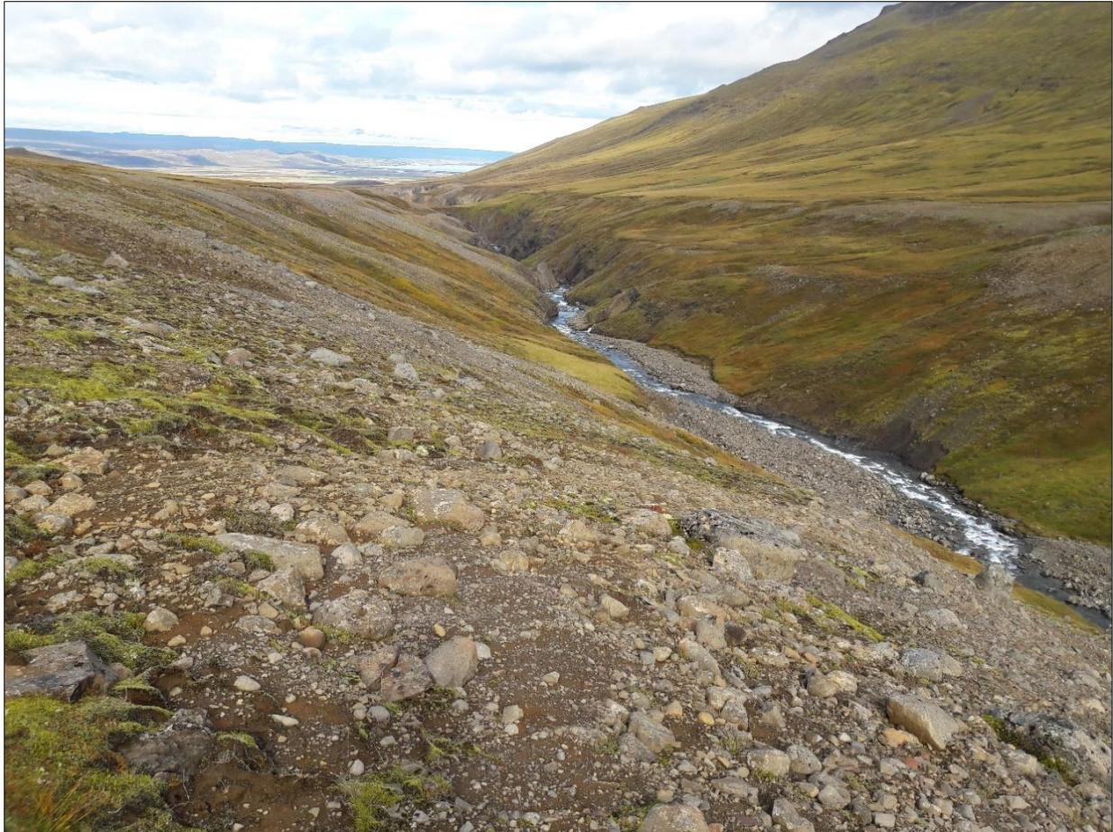
Mynd 5.14 Horft niður með þverá frá stað þar sem stíflan er fyrirhuguð. Þrýstipípan kemur til með að liggja í hlíðinni vinstra (vestan) megin við þverána fyrstu 1.500 metrana áður en hún fer upp á flatann.
